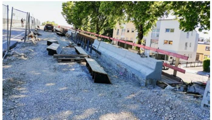
Man sieht rechts außen das Konsolgerüst (Arbeits- und Sicherheitsgerüst aus Holz), ebenso das fertig betonierete Gesims, das auf die bestehende (gut erhaltene) Stützwand aufgesetzt wurde. Wenn dieses Gesims (Brückenrand) komplett neu hergestellt ist, können eine neue Kappe (Gehweg), neue Geländer und ein neuer Fahrbahnbelag hergestellt werden.
